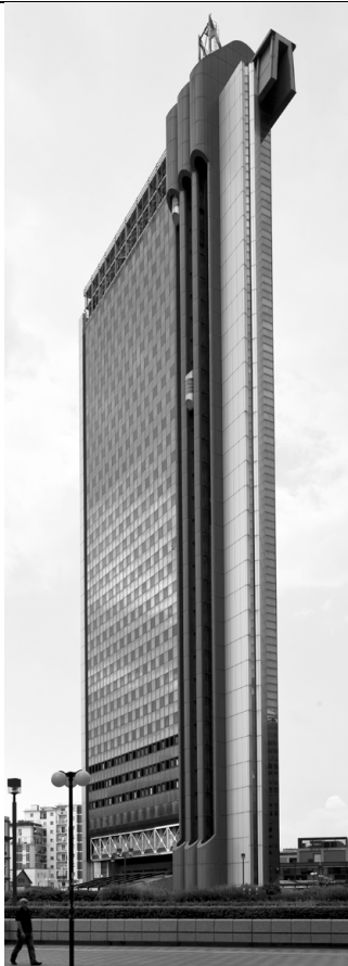
Figura 2 Costruzione Torre "Enel"
