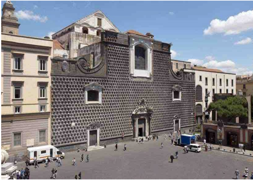
Figura 1 Restauro Chiesa del Gesù
